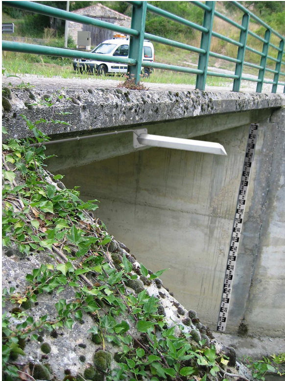
Figure 2 : Photomontage du capteur radar à Teyssière
